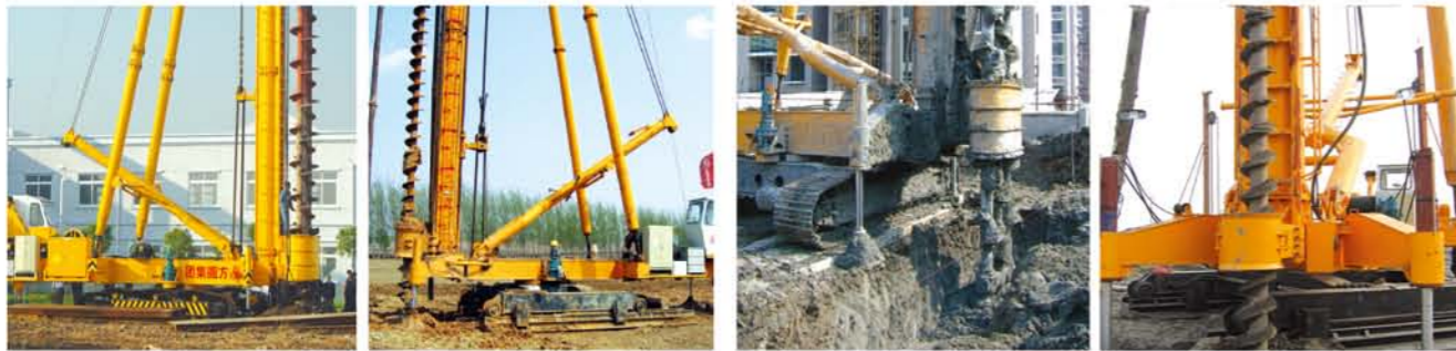
JZL120电动履带式桩机 上海工地 JZB60步履式桩机 哈大高铁工地 SPR650多轴钻机 宁波工地 JZB90步履式桩机 秦皇岛工地
